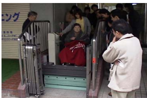
段差昇降機の取付例
