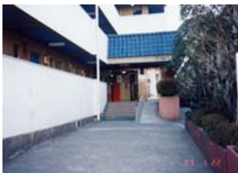
スロープ設置前
