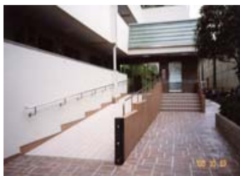
スロープ設置後
