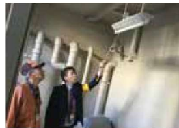
管理員への清掃指導風景。打診棒の先に鏡を付け照器具の裏側の汚れを確認
