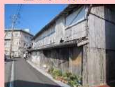
空き家の除却
