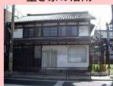
空き家の活用
