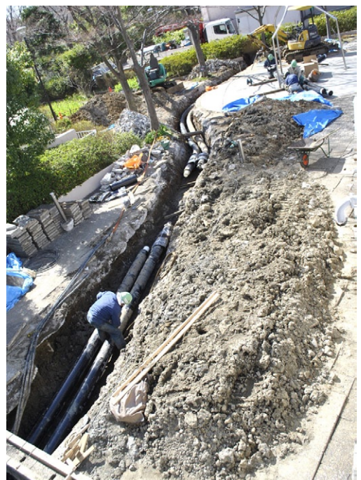
▲震災後の被災の様子。敷地内の給水パイプが破損し、ライフラインが一時寸断された
