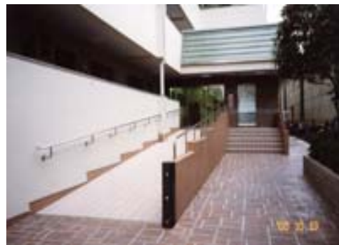
スロープ設置後
