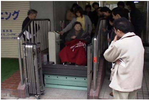
段差昇降機の取付例
